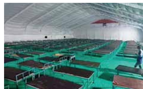
患者増加に対応するための仮設テント (CRHP)
