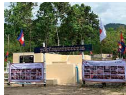
完成した給水施設
